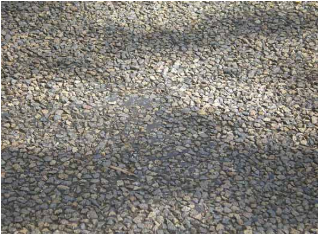
PHOTO 94: Bitumen bleeding
