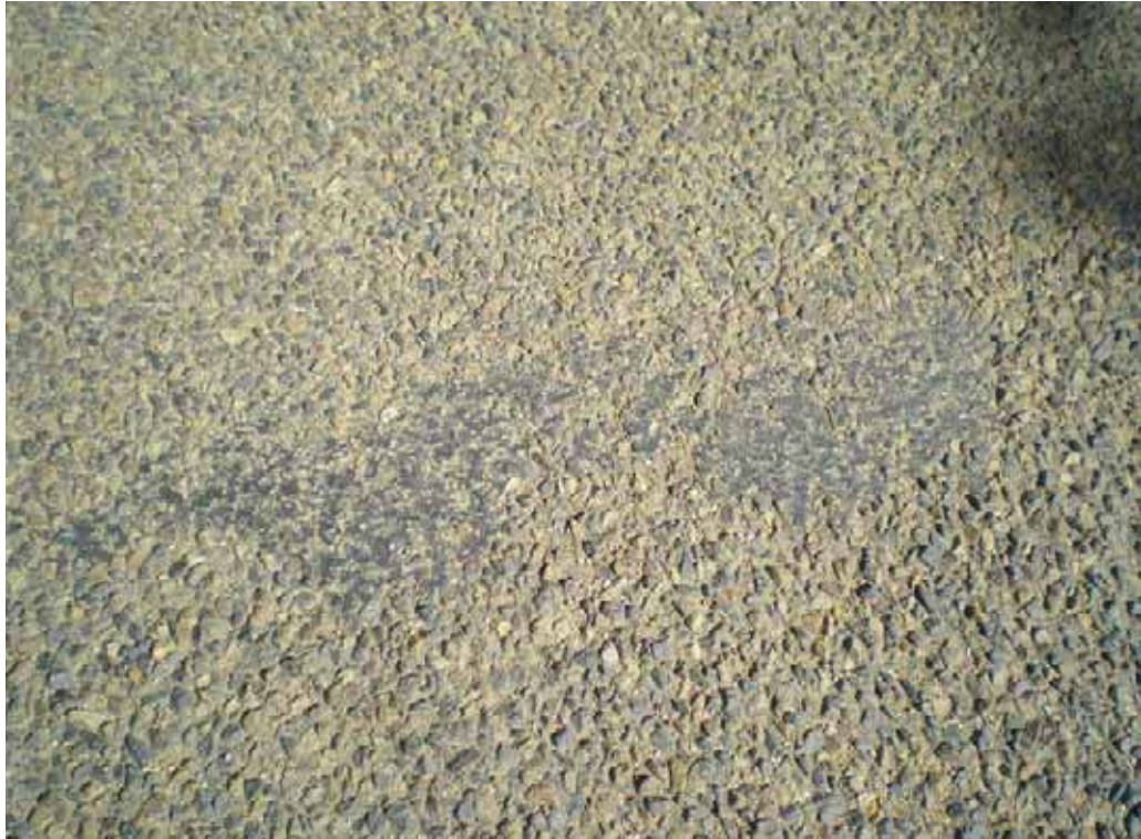
PHOTO 107: Bitumen bleeding
